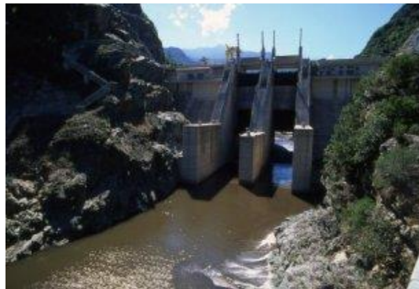
Figure 6 : barrage de Sampolo (source EDF)
